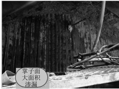
图2 东方之门站—现代大道站区间左线盾构始发洞门破除后情况
