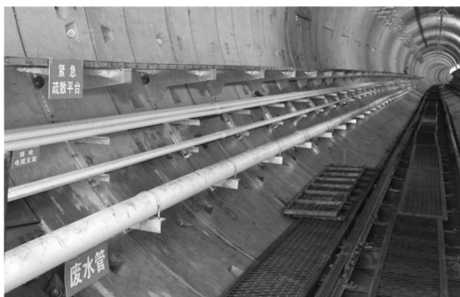
图5 预埋槽道在深圳地铁9号线应用案例
