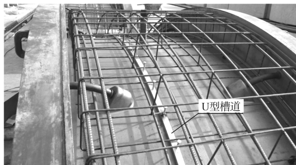
图3 槽道在管片上的安装
