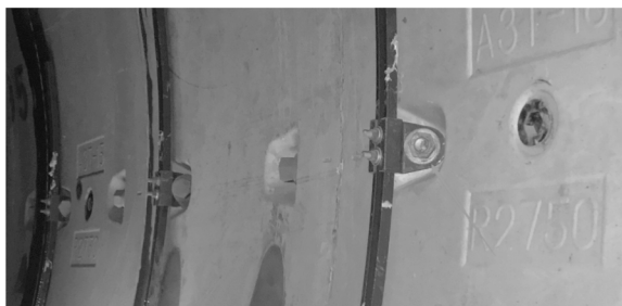
图8 南京地铁宁溧线试验段挂耳+外置槽道实景图
