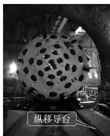
图11 TBM 始发洞内纵向平移
