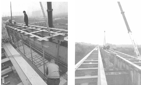
图 2 长沙磁浮工程疏散平台施工照片
