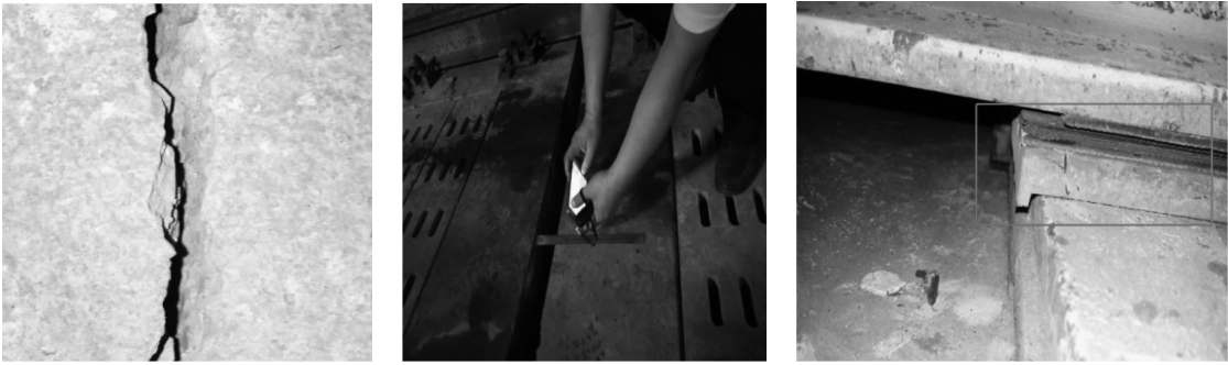
a) 道床有明显的开裂 b) 框架板道床有明显的错台 c) 现场采取道床加高处理
