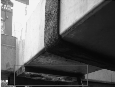
b) 框架板下预粘接的标准橡胶调整块(沉降量 40 \leq x < 50 m)
