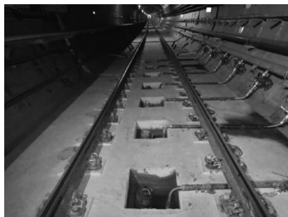
图2 浮置板道床内置式泵房示意图
