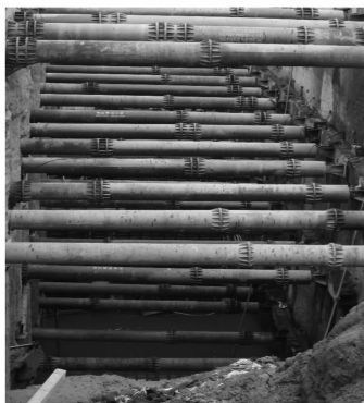
图4 现场排水能力不足导致的基坑积水
