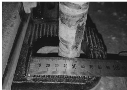
图 5 安装异型铁垫板后的水平调整余量显示
