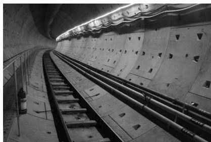
图3 盾构隧道“一纤二道三水三电”和走行系统布置
