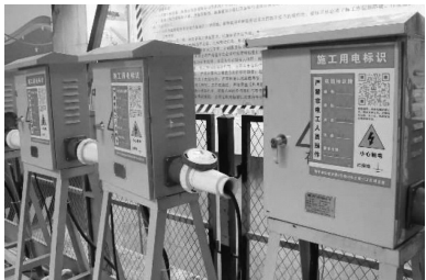
图4 配电箱快速接头及二维码技术应用
