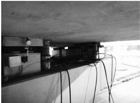
图 5 支座下预先安装顶升设备
