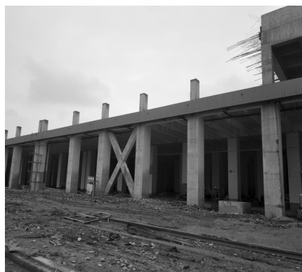
图6 大丰停车场外挂金属天沟施工照片
