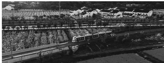
图6 苏州高新有轨电车采用高架线路以保证生物多样性
