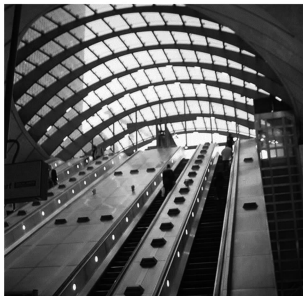
图4 伦敦地铁 JLE 线金丝雀码头站采光设计
