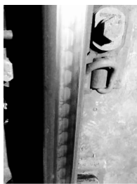
图1 现场钢轨波磨照片
