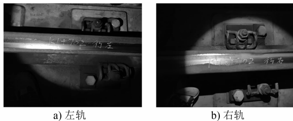
图 13 某线下行线右轨和左轨 K1+702 km 处焊缝平直度故障照片
