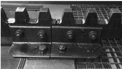
图 2 齿轨轨缝
