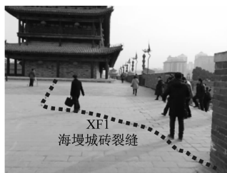
图2 城楼西侧海墁裂缝(镜头向东)
