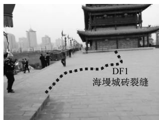
图3 城楼东侧海墁裂缝(镜头向西)
