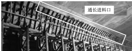
图 5 改进后的逆作接头浇筑模板
