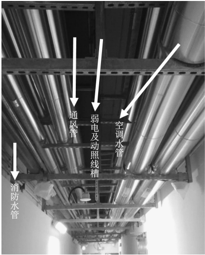
图2 车站设备区走廊常规管线布置
