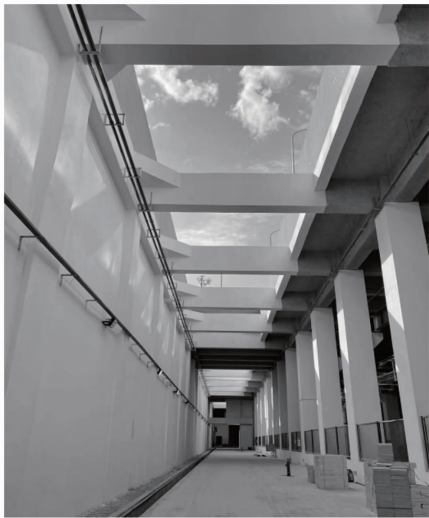
图 7 某城市轨道交通地下车辆基地敞开式消防环路现场图 Fig. 7 Picture of the open fire protection loop of an underground metro depot
