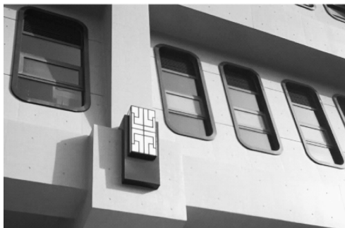
b) 转换梁预应力封锚兼作柱头灯
