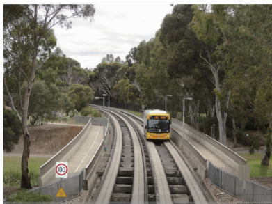
图 3 澳大利亚阿德莱德的导向巴士系统 Fig. 3 Guided bus system in Adelaide, Australia 导向巴士系统。
