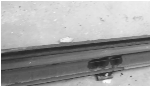
图 8 槽型轨清洁后的实际效果 Fig. 8 Actual effect of grooved track after cleaning
