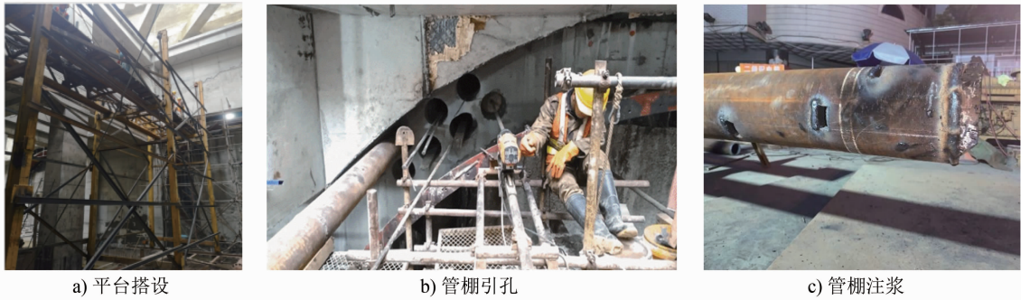
图 5 4 号线隧道管棚施工现场图
