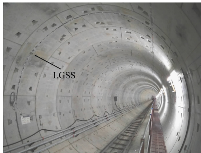
图 1 登花区间盾构管片 LGSS 环向布置现场实物照片 Fig. 1 On-site photo of shield tunnel segment LGSS circumferential layout in Denghua section
