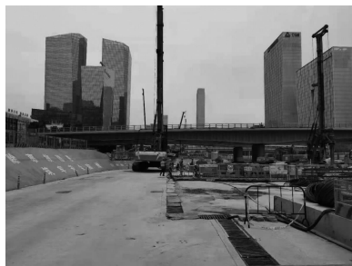
图2 案例基坑的放坡施工实景图
