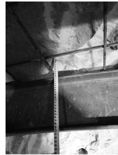
图 8 炮眼优化后拱顶处超挖情况
