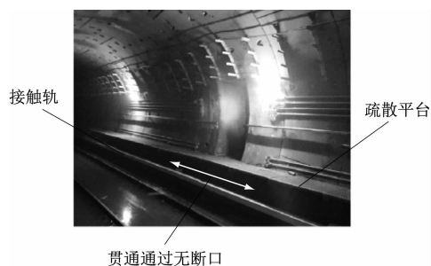
图4 接触轨在联络通道处不断开
