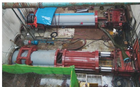
b) 现场顶进施工
