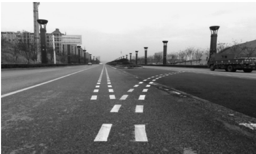
图 2 株洲智轨体验线导向标线
