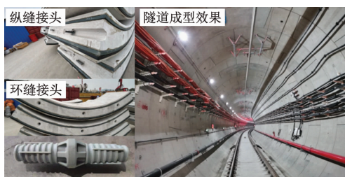
图1 基于新型接头的预埋承插式管片、接头及成型隧道
