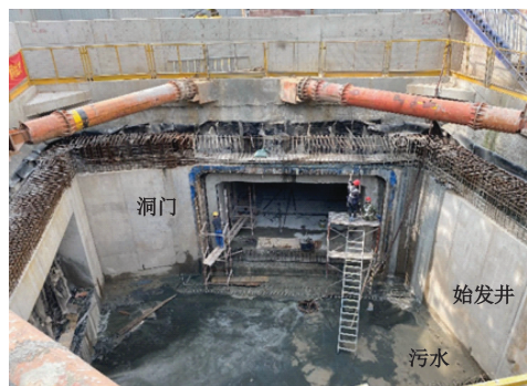
图1 现场始发井污水渗漏情况
