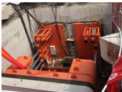
图 8 施工现场的顶推系统
