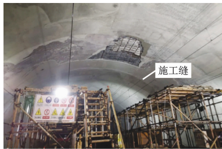
图1 高铁隧道拱部防水板切割混凝土衬砌缺陷现场图
