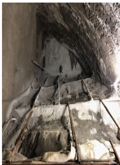
a) 1 # 导洞内封堵掌子面
