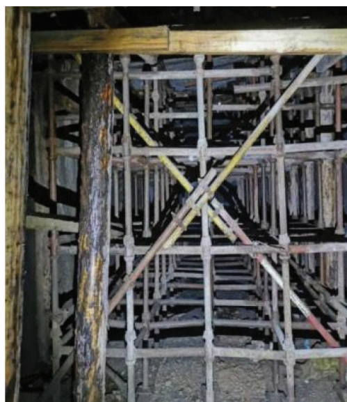
b) 2 # 导洞内架设满堂支架
