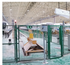
图 1 装在立柱上的人员防护系统开关箱
