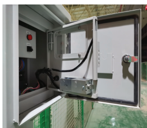
图 2 打开的人员防护系统开关箱
