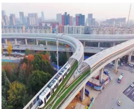
图4 武汉光谷现代有轨电车三通节点高架敷设照片
