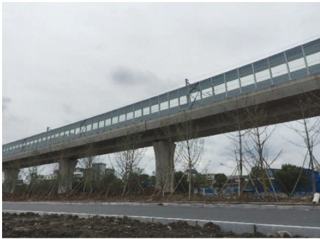
图1 直立式声屏障 Fig. 1 Vertical noise barrier
