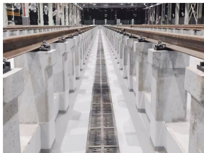
图8 完工后的新型检查坑道床
