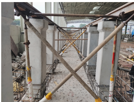
图7 新型检查坑道床架轨法施工现场
