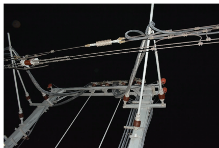
图 4 分段绝缘器现场安装图
