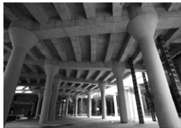
b) 梁柱布置现场效果
