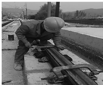
图4 包裹材料仿形夹具
