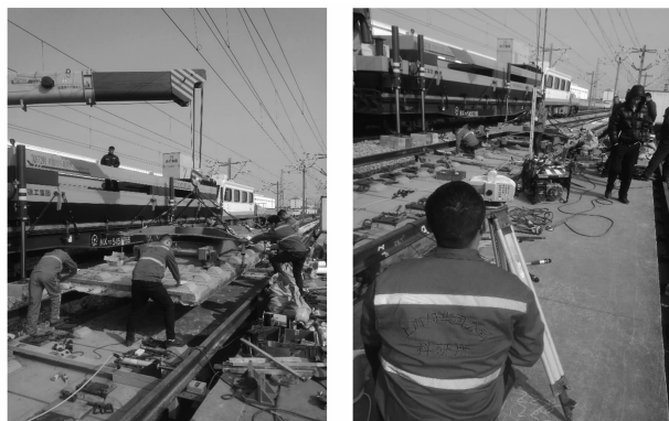
a) 精调装置连接轨道板落位
