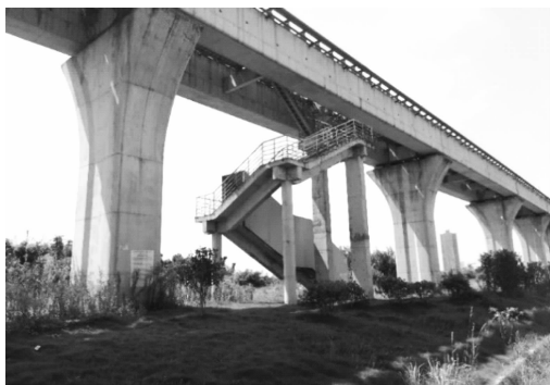
图 10 长沙磁浮快线疏散方式——逃生楼梯
