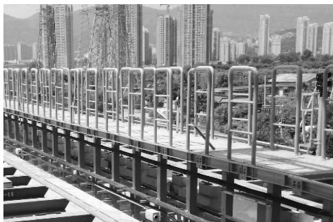
图 7 北京磁浮 S1 线疏散平台
