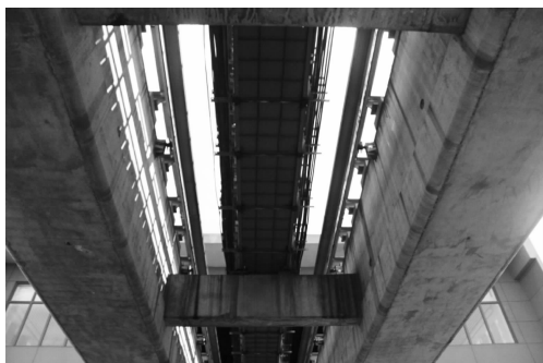
图 8 长沙磁浮快线疏散平台(仰视图)
