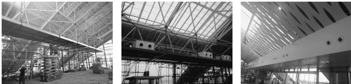
图3 “空中机房”搭建及外观实景图
