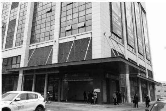
图5 与物业合建的地铁出入口及上方两个活塞风道百叶现场照片
