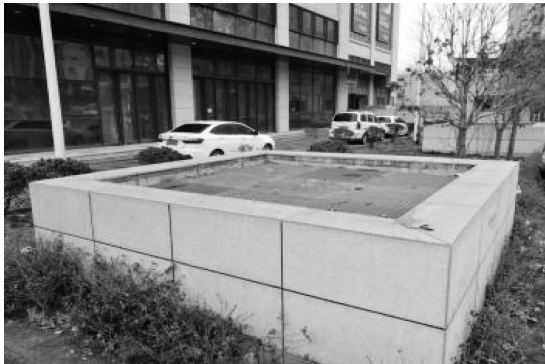
图 9 位于室外的新风、排风口现场照片
