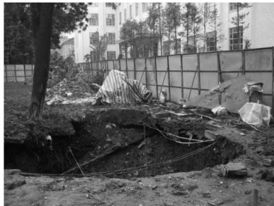
图 6 成都地铁某区段盾构施工引起的地面坍塌
