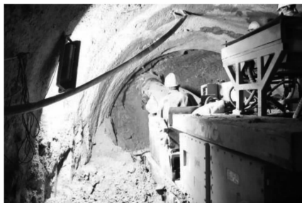
图3 悬臂掘进机施工现场照片
