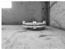
图5 法兰盘封堵
