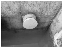
图7 预制橡胶塞封堵
