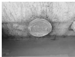
图6 钢板焊接封堵
