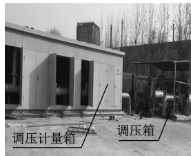
d) 新建的调压计量箱及过滤器设施
