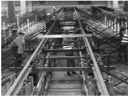
图 2 库内立柱式检查坑整体道床关模实景 专业,首先需对基地坐标进行测设,保持测量的精确;然后对钢轨架设、安装并进行粗调,在安装模板之后再进行精调、报检;最后进行立柱、道床的混凝土浇筑工作。人工架轨常规施工工艺具体流程如图 3 所示。
