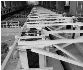
图 8 安装模具
