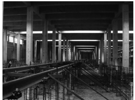
图 1 库内立柱式检查坑整体道床架轨实景
